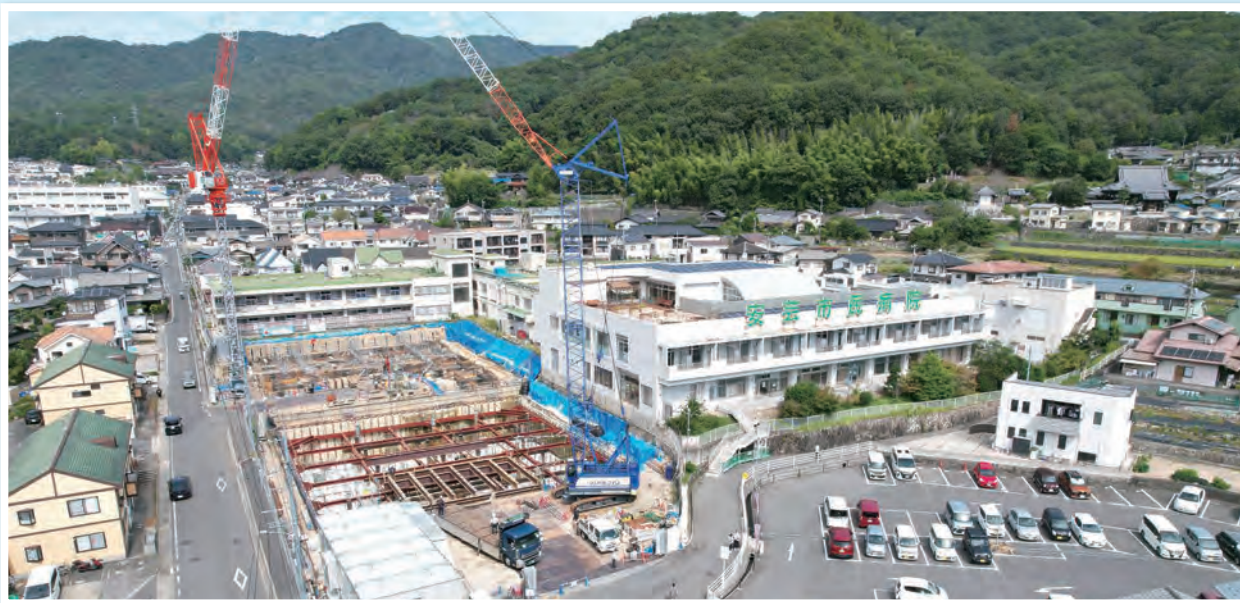
新棟工事の様子(2024年9月27日撮影)
