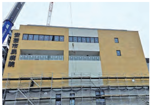
現在の新棟の様子(令和8年2月撮影)
